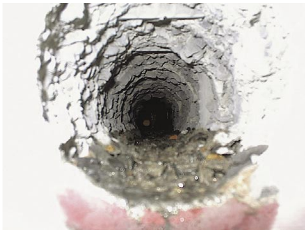
削孔内部状況
