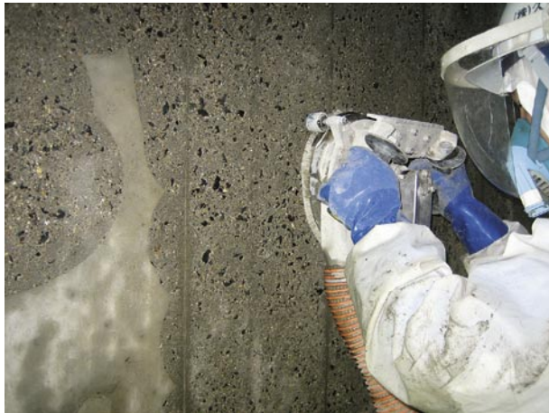
コンクリート表面の目粗し
