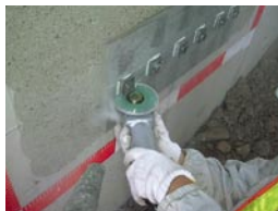
カッター入れ状況
